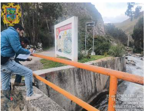
IMAGEN 03: SE MUESTRA EL ESTADO ACTUAL DE LA MARGEN IZQUIERDA DEL RIO PALCA. REQUIERE DE LIMPIEZA Y DESCOLAMATCION Y CONSTRUCCION DE MURO DE CONCRETO
