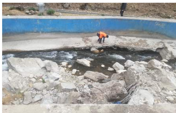
IMAGEN 04: SE MUESTRA EL ESTADO ACTUAL DEL CAUCE DEL RIO PALCA SE REQUIERE DE DEMOLICION DE MURO DE CONCRETO Y EL MEJORAMIENTO MEDIANTE MUROS DE PROTECCION ANTE INUNDACIONES
